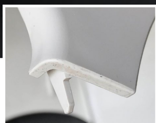
PRZED CZYSZCZENIEM: Elementy zanieczyszczone przez pozostałości formy
